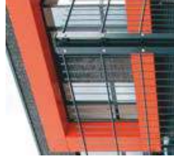
Eckpfosten mit Winkelstanzhalter
